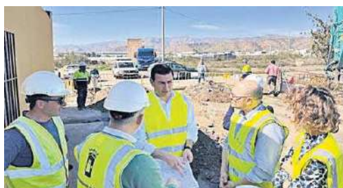
Visita del alcalde a las obras de abastecimiento.
