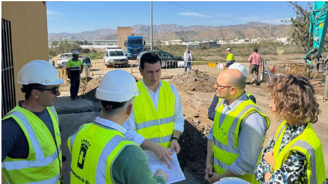
Visita del alcalde a las obras de abastecimiento.
